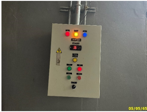
ตู้ควบคุมระบบบำบัด และท่อรวบรวมน้ำเสีย
