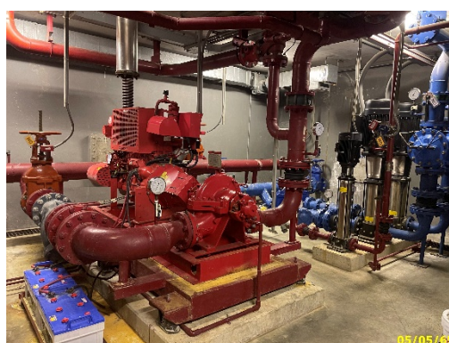
เครื่องสูบน้ำและเครื่องสูบน้ำดับเพลิงชั้นใต้ดิน
