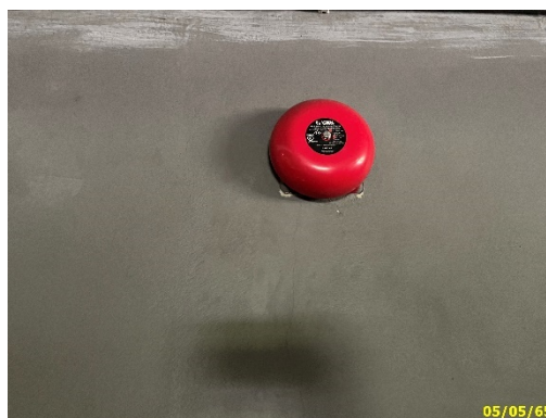
อุปกรณ์ส่งเสียงสัญญาณเพื่อให้หนีไฟ
